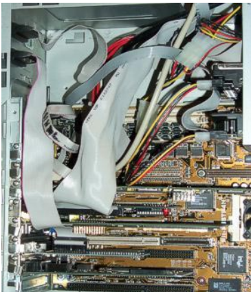
schlechte Kabelführung von Strom- und Datenkabeln
